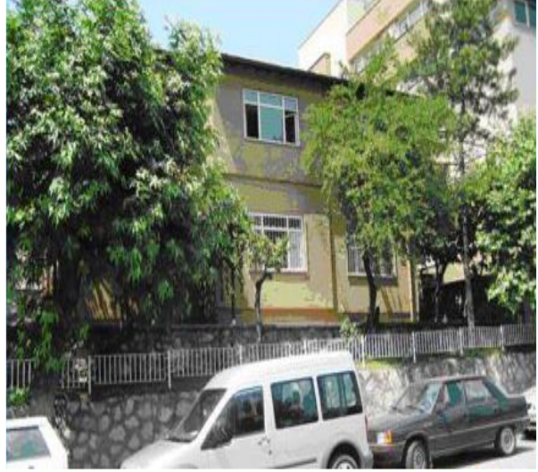
Eski Hizmet Binası
